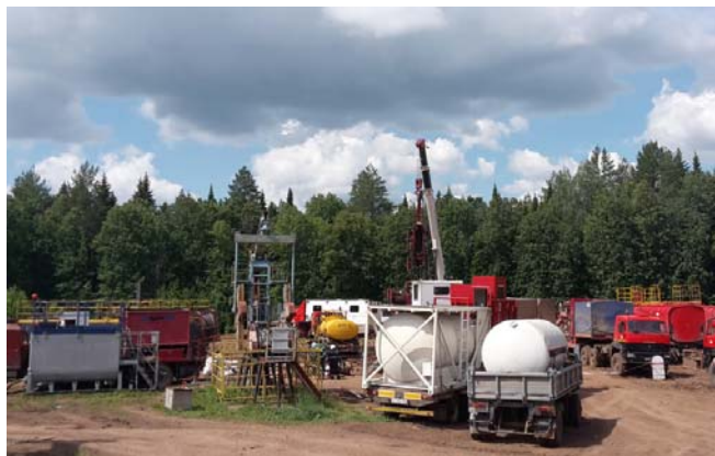
Рисунок 3 – Проведение работ Plug&Perf на Казанчинском месторождении
